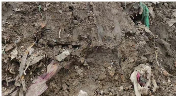
图 2-5 本项目表土调查现场图
